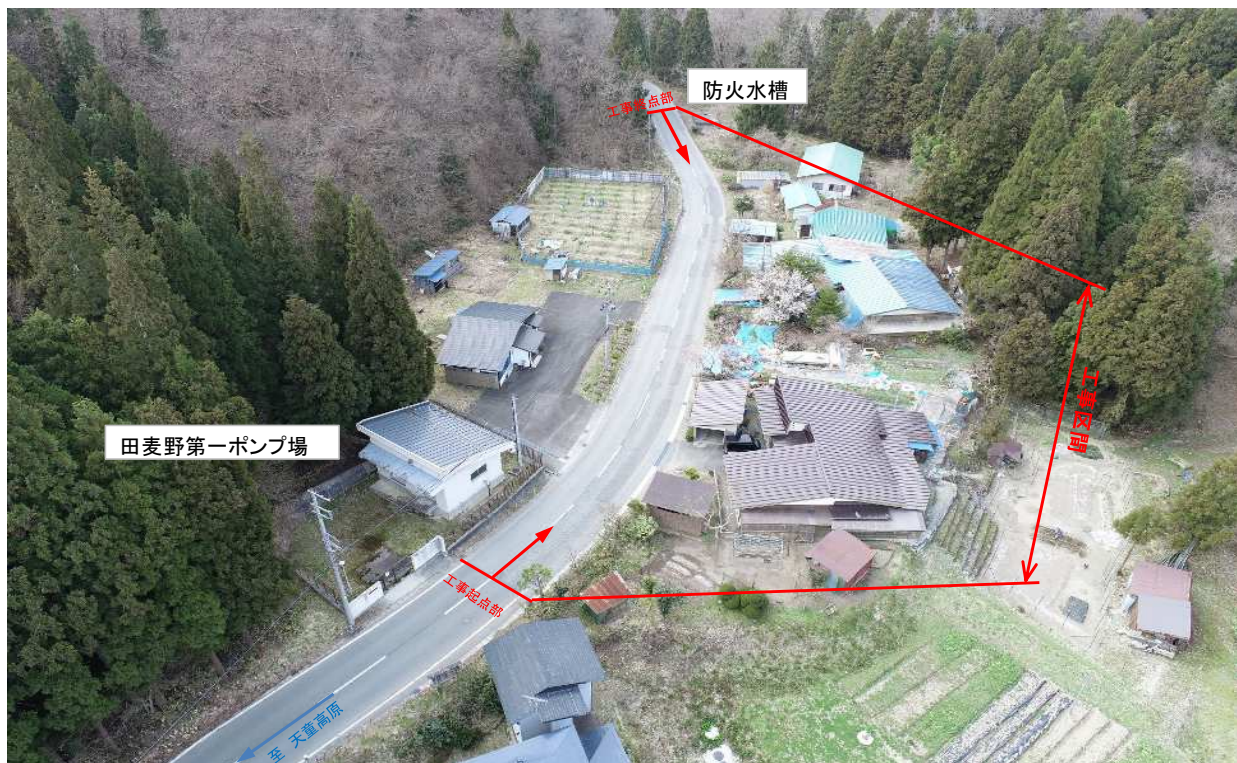
施工前 現場空撮写真
