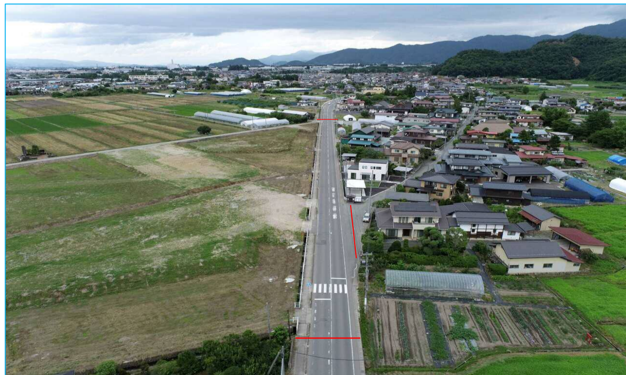
南側より北側を望む
